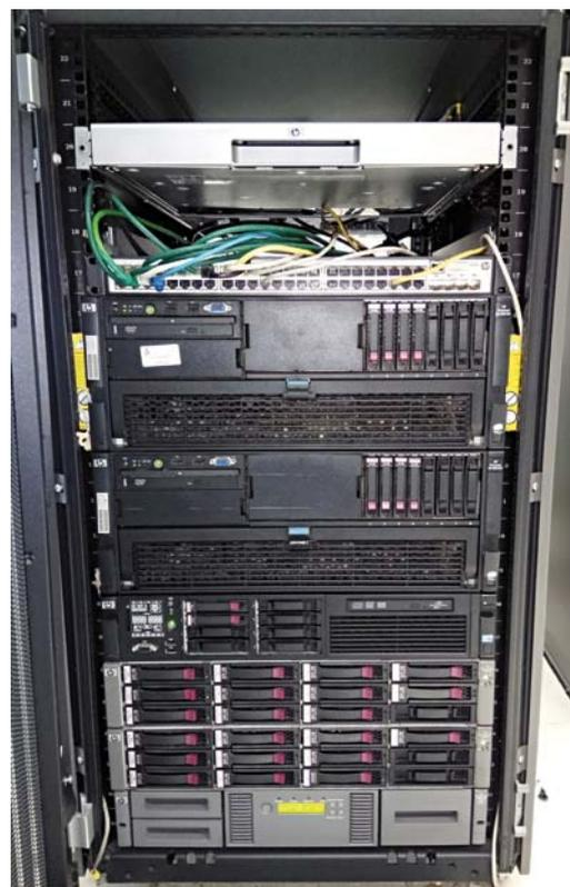
La Sala Operativa ospita due server ridondati e due NAS di archiviazione per conservare le registrazioni fino a 7 giorni. Tutto il sistema è anche accessibile dall'esterno, tramite SIM – in dotazione alle forze di polizia – che operano su rete MPLS.
