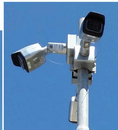
Un palo di sostegno per tre telecamere Panasonic WV-SPV781L, true 4K. Sotto, un armadietto blindato che comprende un server e le apparecchiature studiate per replicare un piccolo CED.
